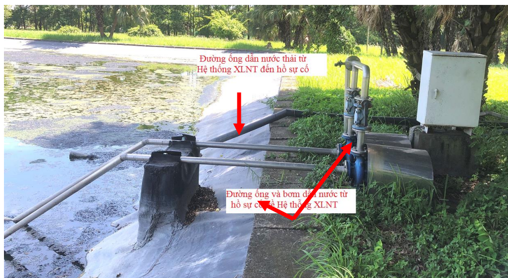
Hình 5. Van xả nước thải ra hồ sự cố (trong trường hợp gặp sự cố nước thải) và van xả nước thải ra nguồn tiếp nhận (sông Hồng)
