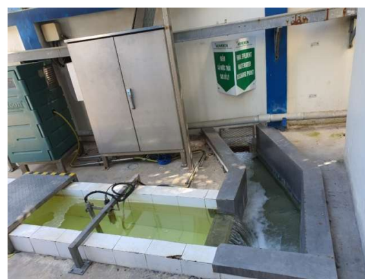
Hệ thống thu gom nước thải khu vực bên trong nhà xưởng
