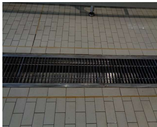
Hệ thống thu gom nước thải khu vực bên trong nhà xưởng
