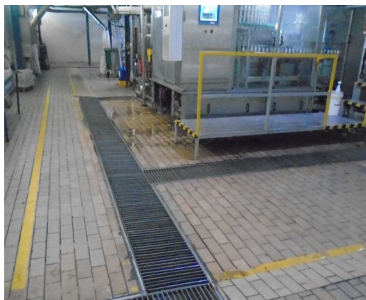
Hệ thống thu gom nước thải khu vực bên trong nhà xưởng
