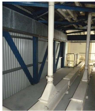
Hệ thống ống hút bụi tải gạo từ silo
